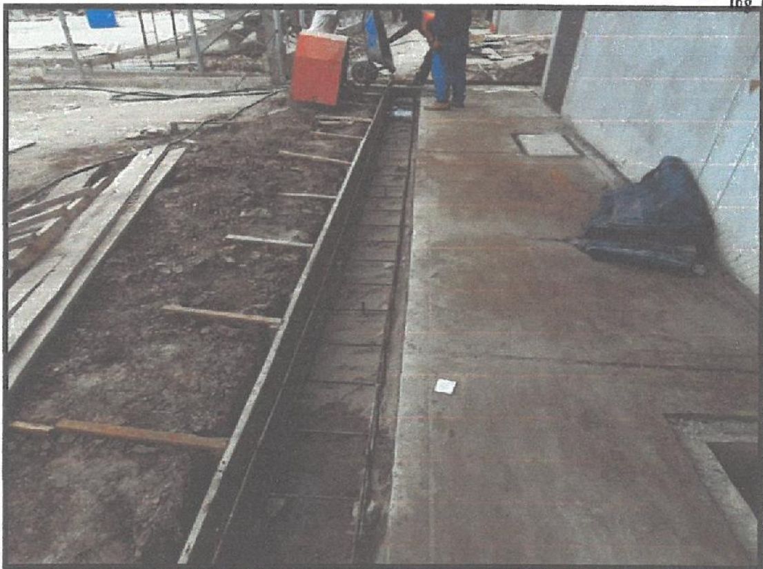
IMAGEN Nº 04: SE PUEDE OBSERVAR TRABAJOS DE HABILITACION DE ACERO CORRUGADO Ø 3/8" Fy=4200 kg/cm2 EN CUNETAS.
