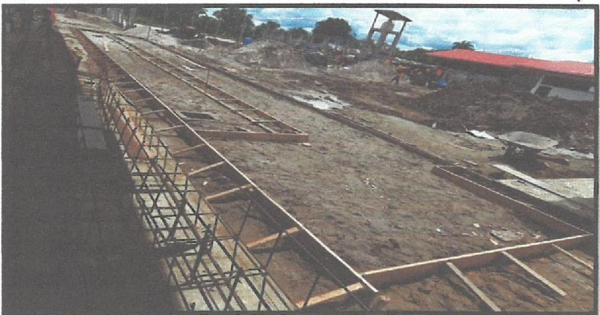
IMAGEN Nº 02: EN LA FOTO SE OBSERVA TRABAJOS DE ENCOFRADO DE VEREDAS
