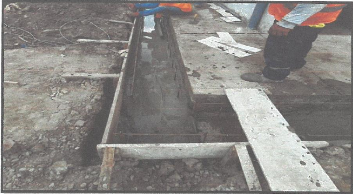
IMAGEN Nº 05: EN LA FOTO, TRABAJOS DE VACEADO DE CONCRETO f'c=175 \text{ kg/cm}^2 EN CUNETAS
