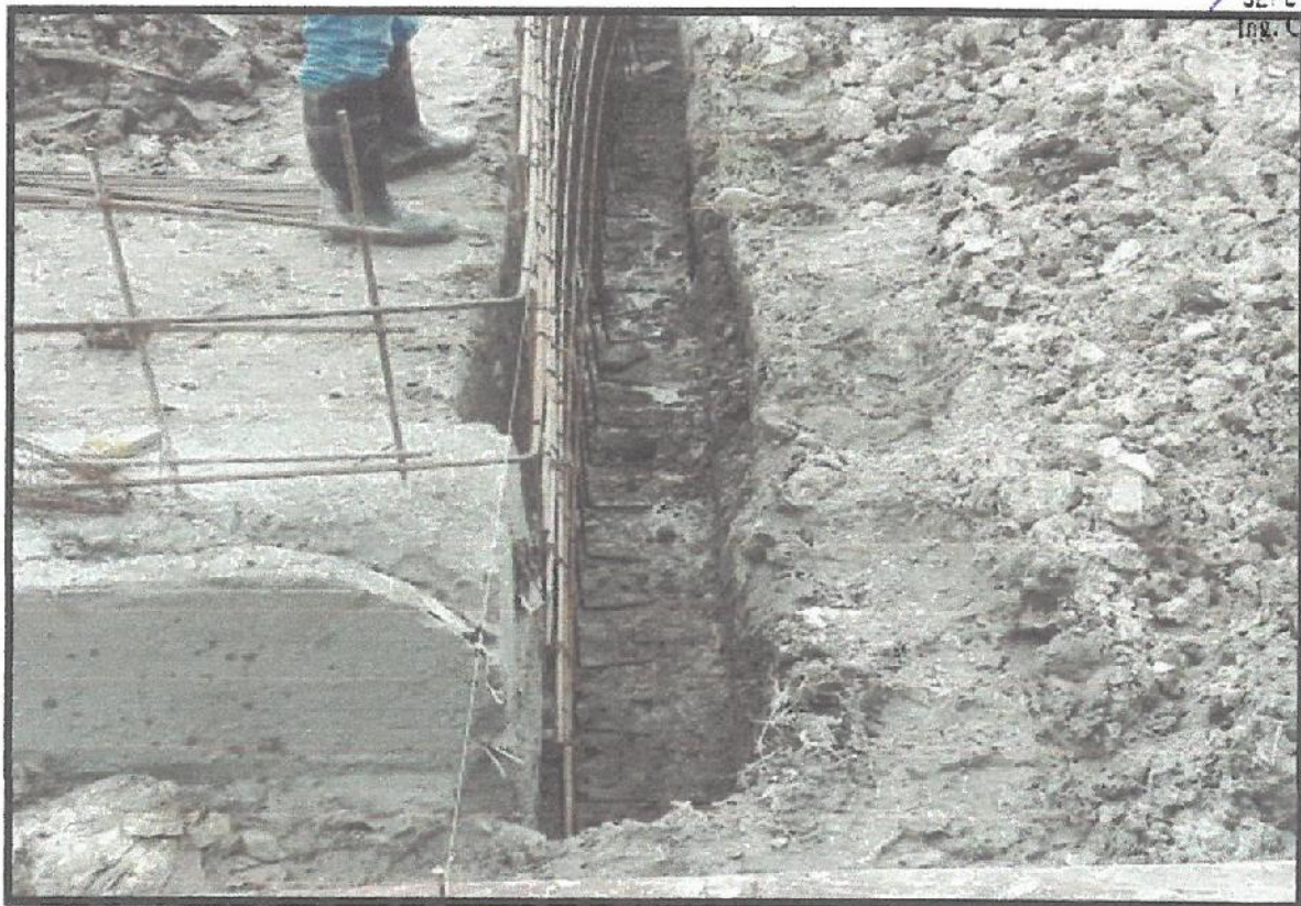
IMAGEN Nº 06: SE MUESTRA TRABAJOS DE EXCAVACION DE ZANJAS PARA CUNETAS
