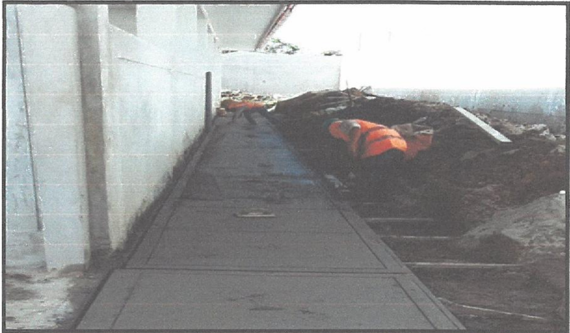
IMAGEN Nº 01: EN LA IMAGEN SE PUEDE OBSERVAR TRABAJOS DE CONCRETO F'C= 175 kg/cm 2 E=4" EN VEREDAS.
