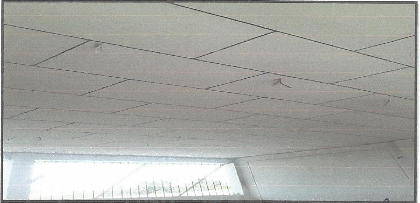
IMAGEN Nº 07: EN LA IMAGEN SE OBSERVA TRABAJOS DE COLOCACION DE CIELORASOS DE PLANCHA DE SUPERBOARD.
